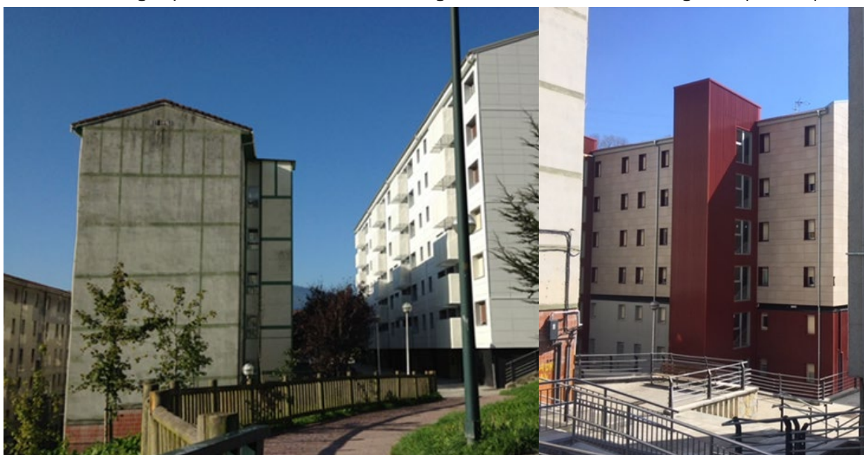
Fig. 5. 8. Instalación de ascensores en Otxarkoaga (Bilbao).
