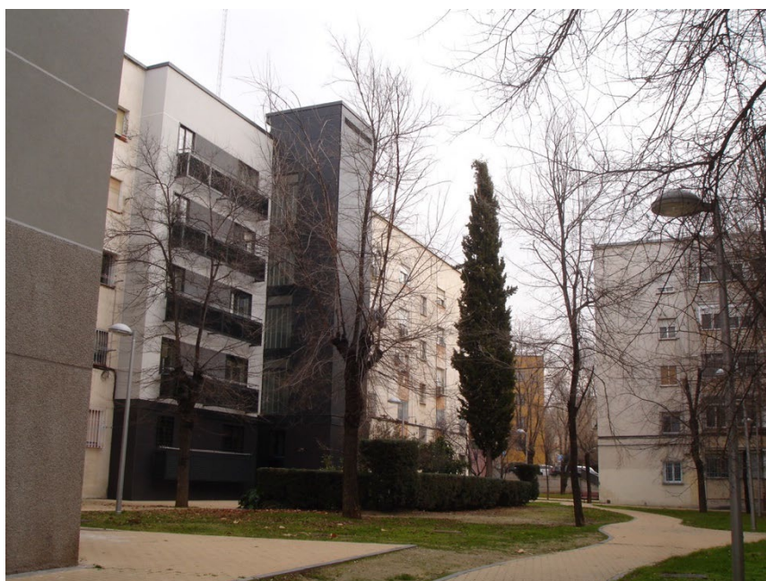
Fig. 5. 10. Instalación de ascensores en Madrid.
