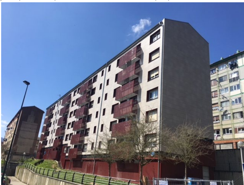
Fig. 3. 3. Edificio rehabilitado en Otxarkoaga.
