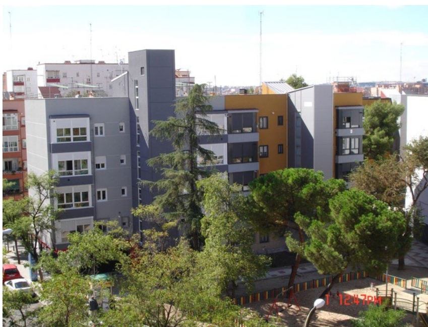
Fig. 5. 9. Instalación de ascensores en Ciudad de los Ángeles (Madrid).
