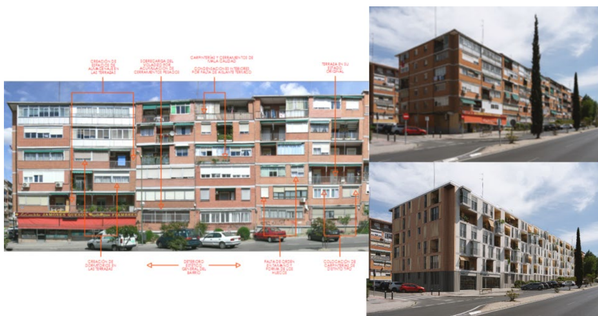
Fig. 3. 9. Propuesta de rehabilitación de la Colonia Puerto Chico (Madrid). A la derecha, imagen de antes (arriba) y después (debajo de la rehabilitación).
