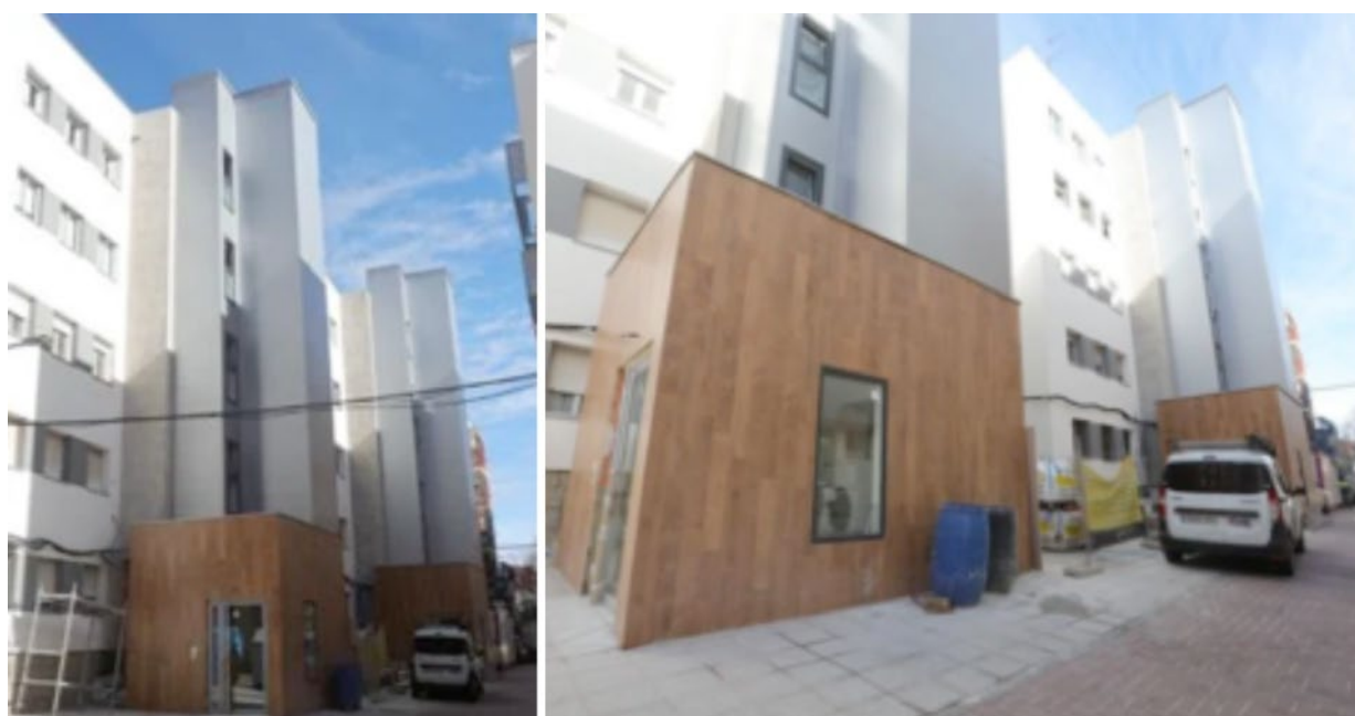
Fig. 5. 7. Instalación de ascensores en Salamanca.
