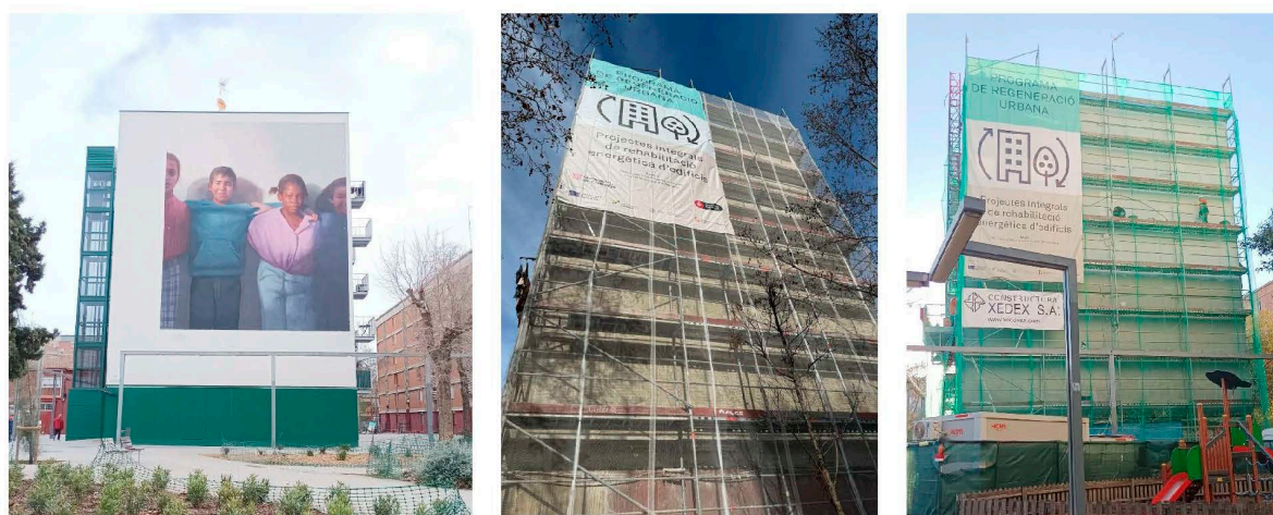
Fig. 2. 8. Rehabilitación de viviendas en Barcelona.
