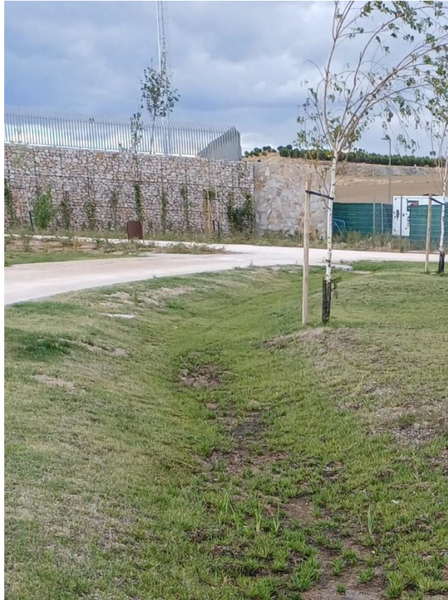
Figura 6.17 Cuneta vegetada en el nuevo Parque Ferial de Fuenlabrada (Madrid). Fuente: Green Blue Management (Grupo TYPESA)
