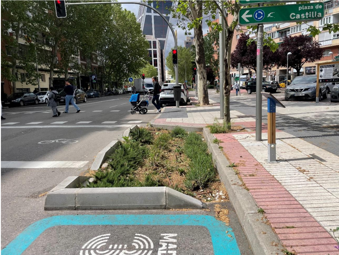
Figura 6.15 Área de biorretención en la calle de Agustín de Foxá (Madrid). Fuente: Ayuntamiento de Madrid.
