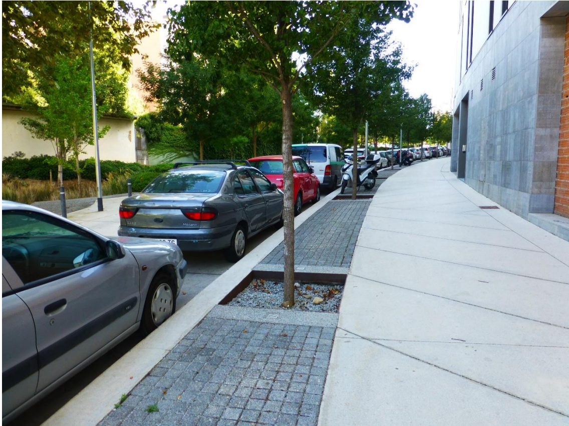
Figura 6.18 Alcorques estructurales en el barrio de Can Cortada (Barcelona). Fuente: Roberto Soto-Instituto Municipal de Urbanismo, Ayuntamiento de Barcelona
