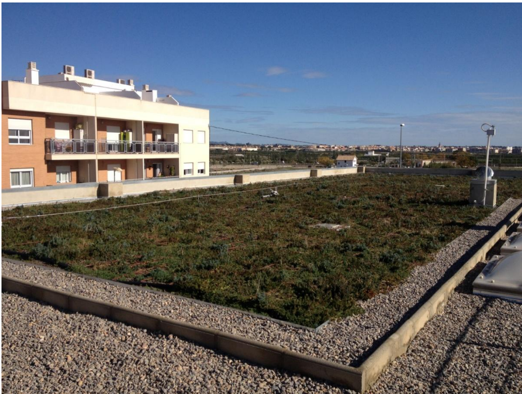
Figura 6.13 Cubierta vegetada en Benaguasil (Valencia). Fuente: Green Blue Management (Grupo TYP SA).
